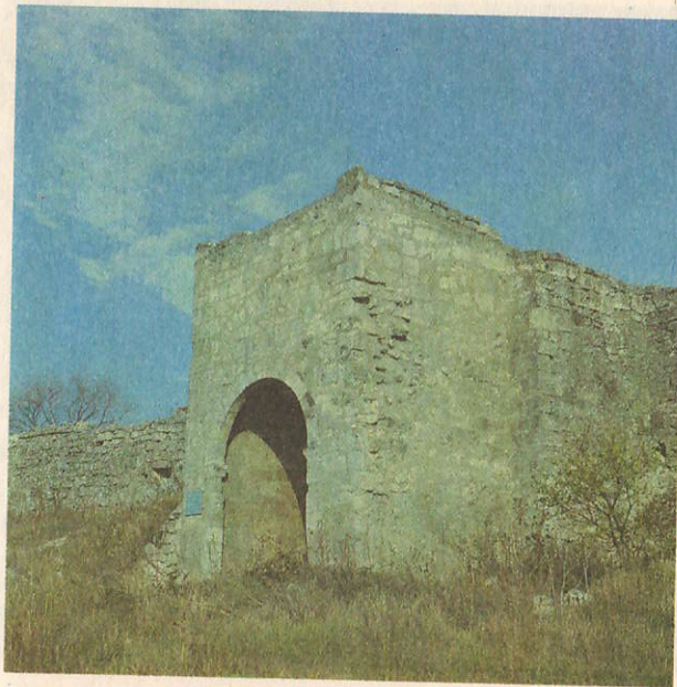
Башня Бикок-капу. Следы пристройки первоначальной южной куртины.
